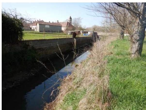
Secteur amont, aux abords du site communal avec le lavoir
