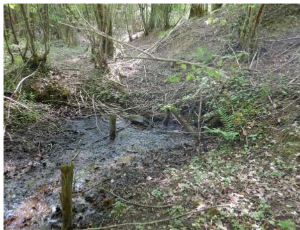
Localisation de l'ancien ouvrage de vidange
