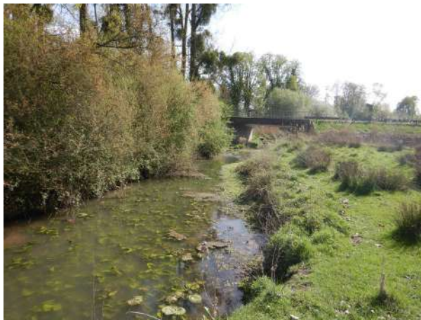
Secteur amont (pont de la D2076 en arrière-plan)
