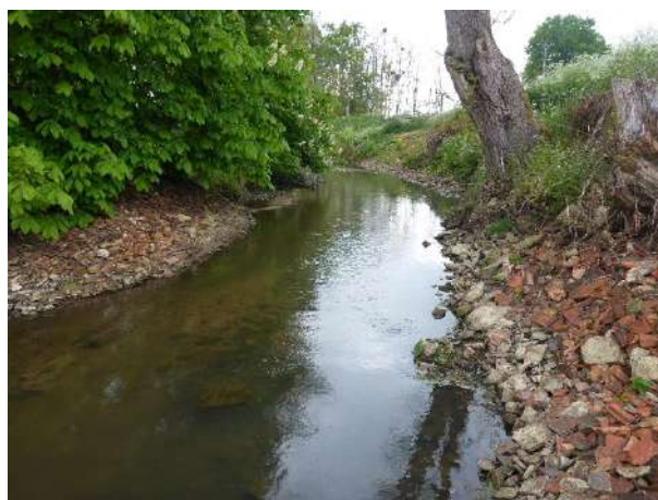
Secteur en aval de l'ouvrage avec les érosions en rive droite et rive gauche
