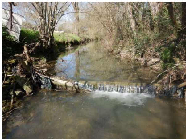
Secteur médian : cours d'eau rectifié et recalibré aux abords des jardins. Présence d'un petit seuil rustique (0.25 m de chute).
