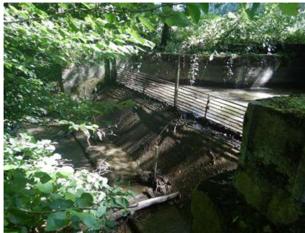
Déversoir (0.6 m de hauteur de chute)
