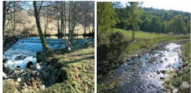
Exemple de l'Alagnon (15) avant et après l'effacement d'un ouvrage.
