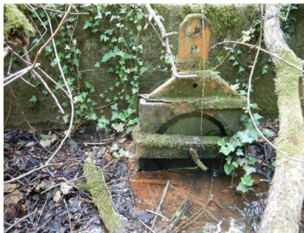
Ouvrage de vidange (OH447)
