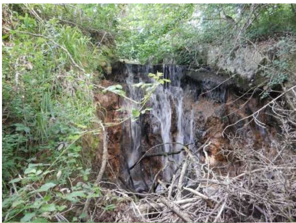
Vue aval de l'ouvrage et de l'incision du lit
