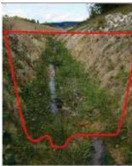
Exemple d'un cours d'eau rectifié et recalibré avant et après retalutage. (Source : BRAMARD, La restauration morphologique de nos rivières)
