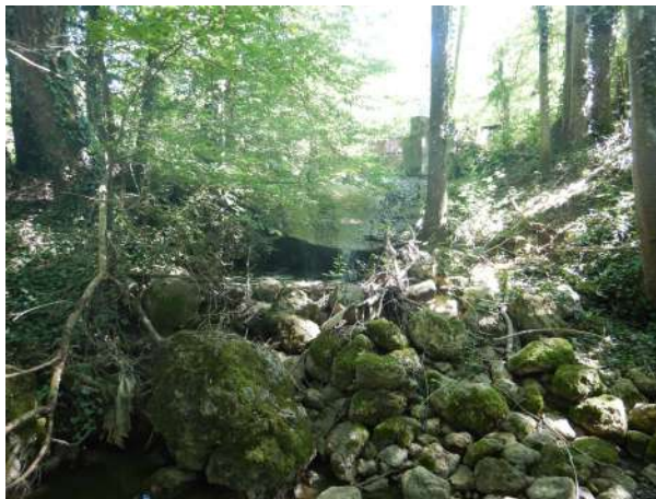
Chutes en aval du déversoir
