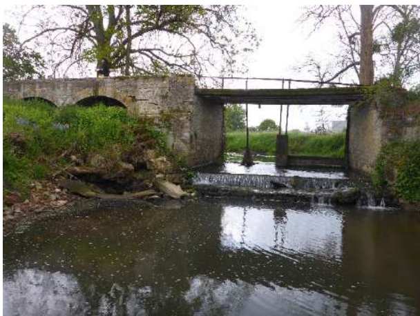
Vue aval de l'ouvrage
