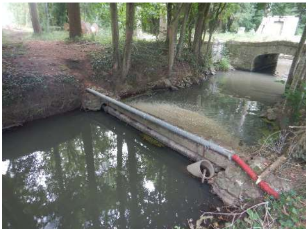
Canalisation à conserver en l'état en amont du site
