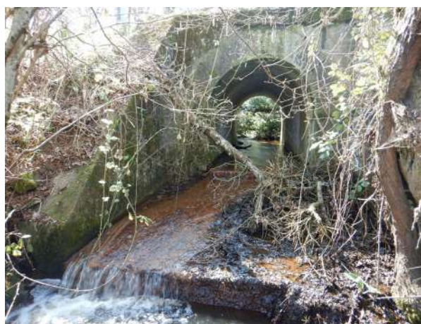
Radier de pont du chemin de Villeneuve
