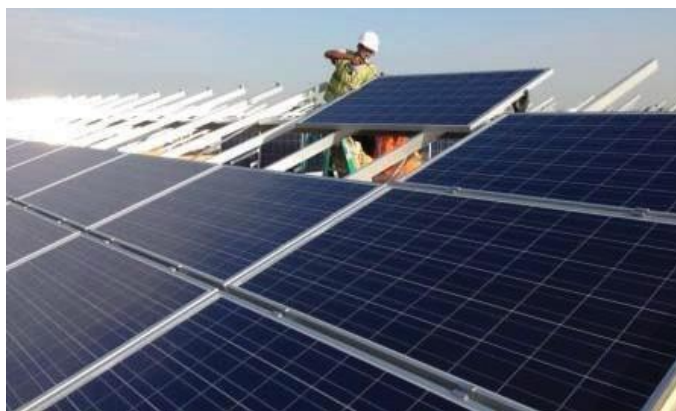
Photo 23 : Exemple de mise en place des panneaux sur les structures (Escofi)
