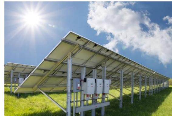
Figure 8 : Onduleurs décentralisés
