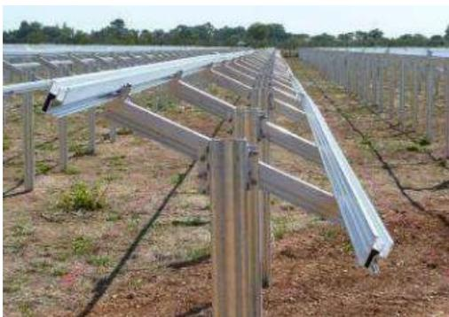
Figure 7 : Structures avant pose des panneaux
