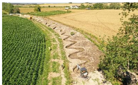
Restauration de l'Yèvre à Baugy, SIVY 2020
