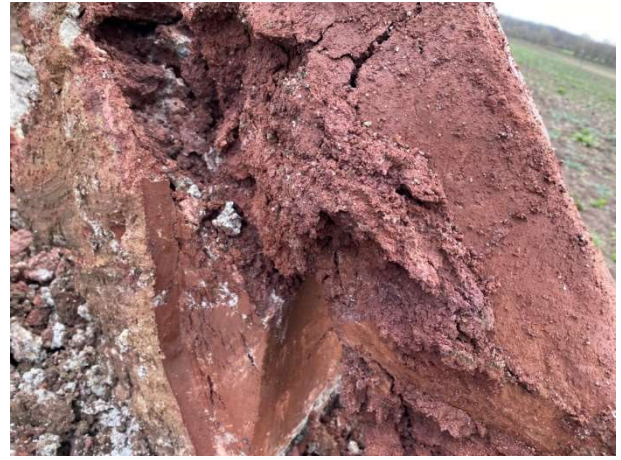
Fond de fouille
