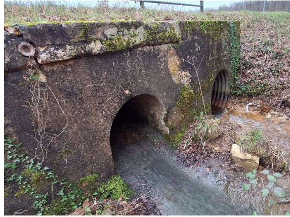
Ouvrage vu depuis l'aval
