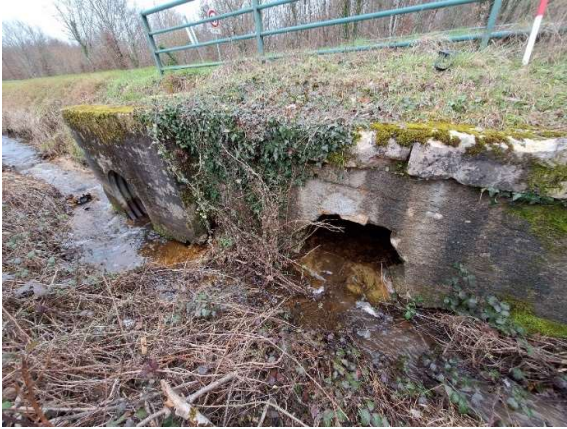
Ouvrage vu depuis l'amont
