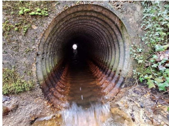
ARMCO vu depuis l'aval
