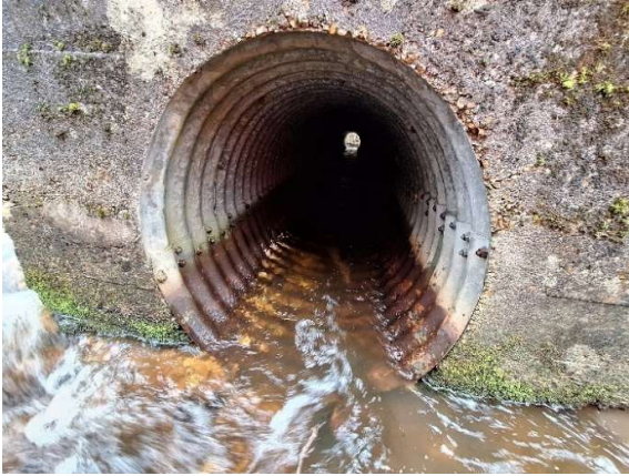
ARMCO vu depuis l'amont
