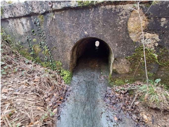
Ouvrage maçonné vu depuis l'aval
