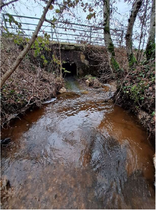
Vue aval de l'ouvrage
