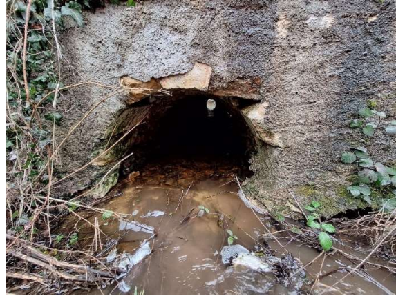
Ouvrage maçonné vu depuis l'amont
