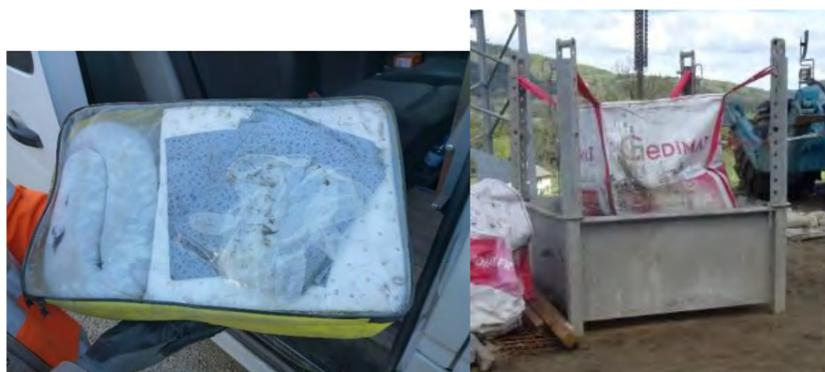
Figure 43 : Kit anti-pollution (EDF Renouvelables) et de bac étanche de décantation pour les laitances béton (Eco-Stratégie)
