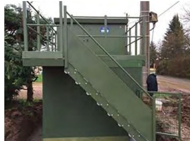
Figure 13 - Exemple de poste de transformation et de livraison HTA/BT réhaussé (rehausse pssa, s.d.)
