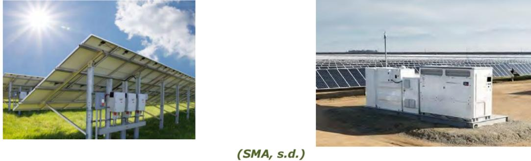
Le choix d'un ensemble d'onduleur string ou d'onduleurs centralisés est spécifique à chaque projet photovoltaïque. Ils dépendent de la supervision désirée et de l'équilibre des pertes électriques DC et AC.
