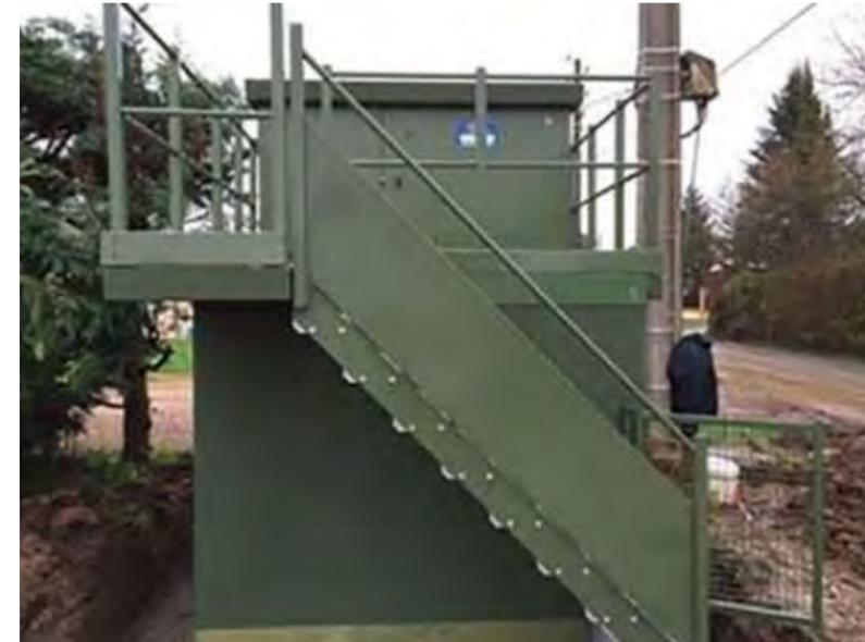
Figure 14 - Exemple de poste de transformation et de livraison HTA/BT réhaussé (rehausse pssa, s.d.)
