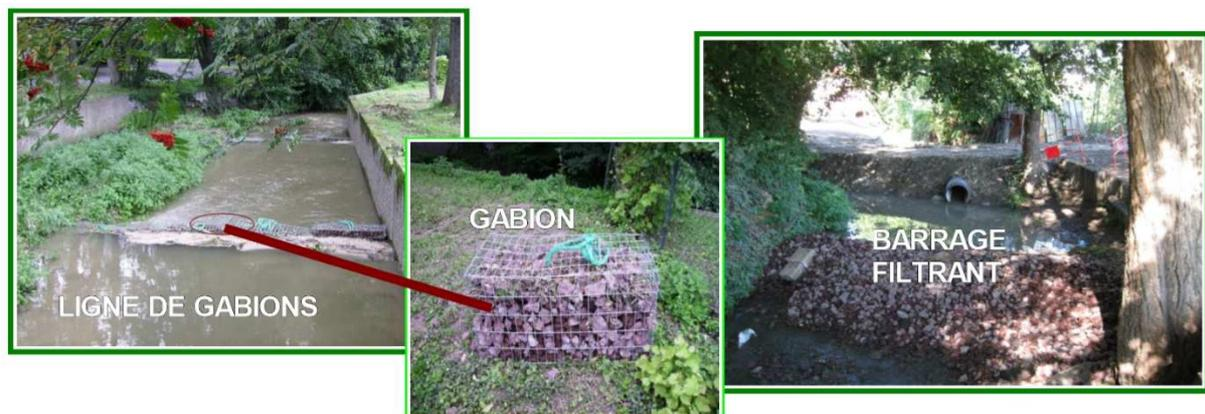
Figure 39 : Exemple de barrages filtrants en gabions
