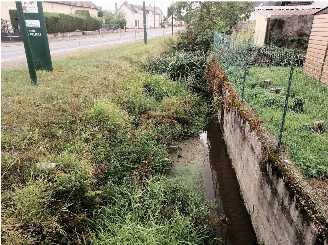
Figure 18. Vue depuis l'aval du seuil en enrochement et du cours d'eau, envahi par de la végétation
