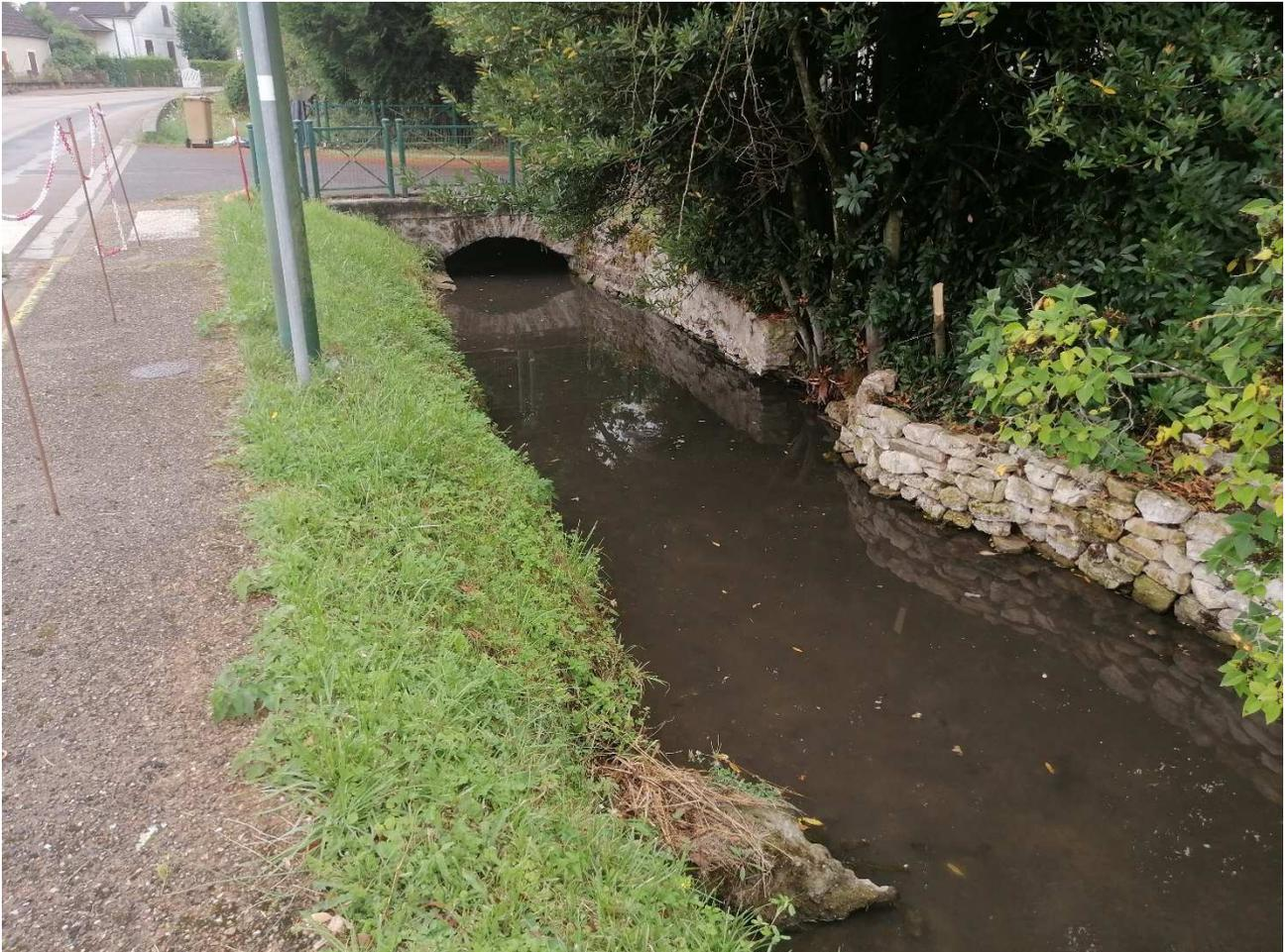
Figure 12. Vue depuis l'aval du point de l'impasse des Barrois. *Les piquets de travaux indiquent la zone soumise à érosion*
