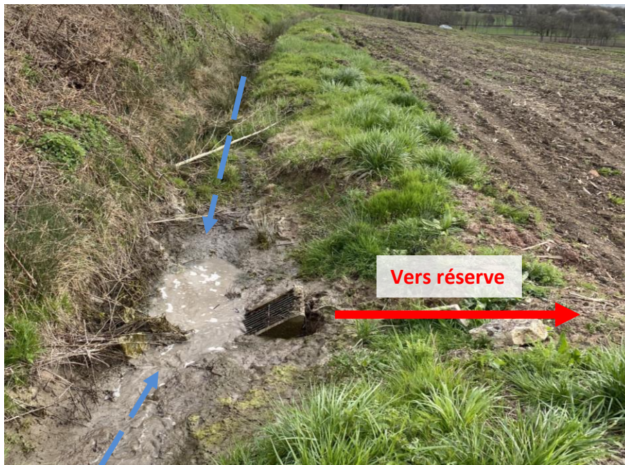
Figure 3: Photographie de la prise d'eau Ouest
