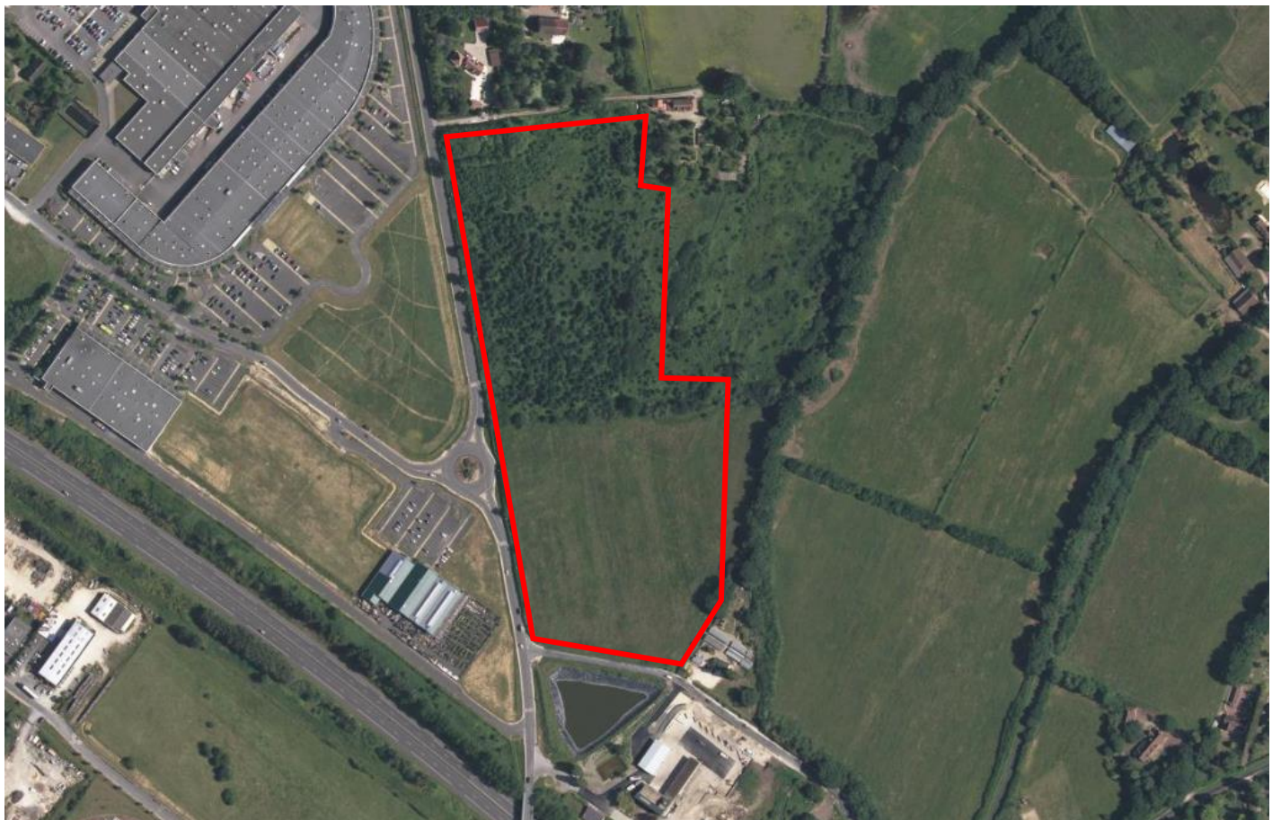
Figure 2 : Vue aérienne du site étudié (Géoportail – sans échelle)
