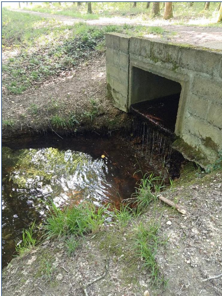
**Figure 8 : Importante chute avec fosse à l'aval du pont cadre (Source : SIVY - 05/2023)**
