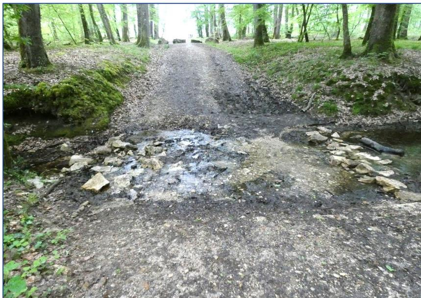
Figures 16 et 17 : La descente en rive droite présente un aspect en partie dégradé par le passage des véhicules
