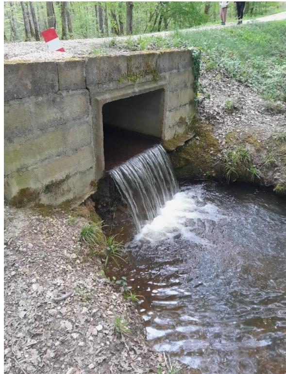
Prise de mesure sur le ruisseau en amont de l'ouvrage existant -Photo du pont cadre actuel illustrant les désordres et les ruptures de la continuité écologique.
