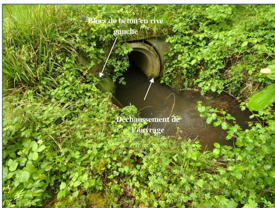
Figure 24 : Déstabilisation du passage busé à l'amont (Source : SIVY - 05/2023)
