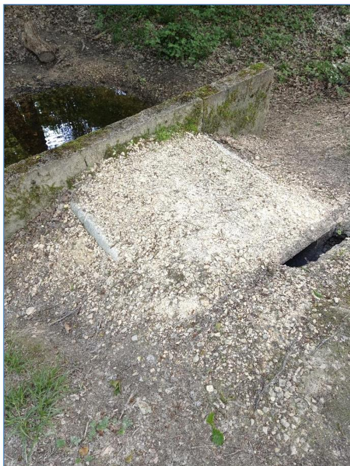
Figure 7 : Dislocation du pont cadre au niveau de la route forestière (Source : SIVY - 05/2023)
