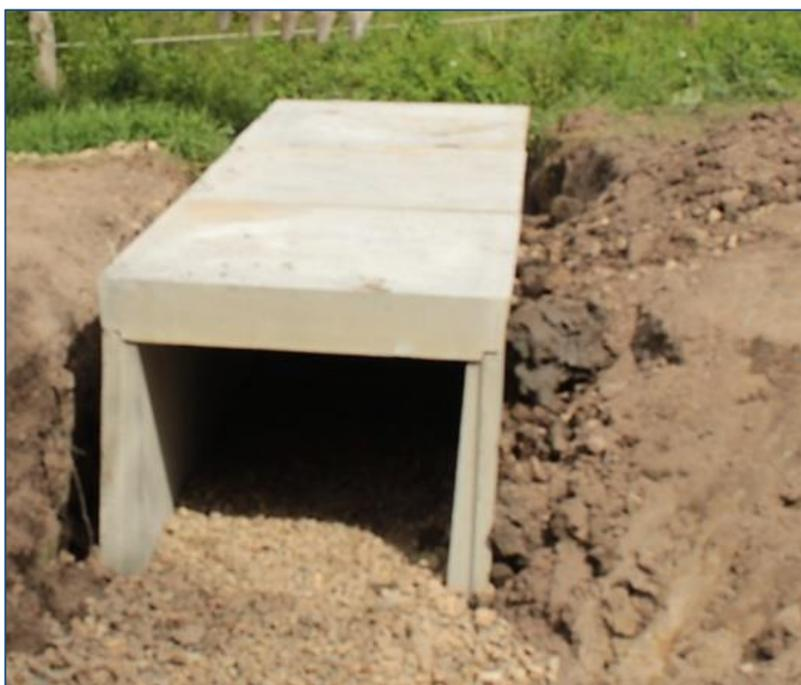
**Figure 15 : Exemple d'un pont cadre en béton à Méry-ès-Bois (Source : SIVY)**
