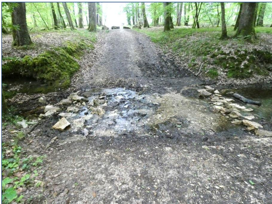
**Figure 17 : Le passage à gué au niveau du chemin rural de Bléron aux Roches. On distingue au fond les blocs destinés à empêcher les véhicules à emprunter le gué (Source : SIVY - 05/2023)**
